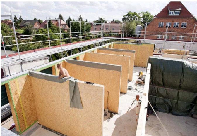
Grundgedanke ist, die dampfsperrende Kunststoffbahn auf der Innenseite der Bauteile zu vermeiden. Das wesentliche Merkmal des Systems ist daher die im Gegensatz zum konventionellen Holzrahmenbau innen liegende tragende Holzwerkstoffbeplankung. Diese wird dadurch zum multifunktionalen Bauteil und übernimmt die Funktionen:
